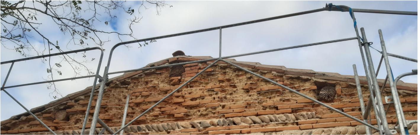
Nous avons pour cela réalisé deux mélanges, avec de la terre que nous avons nous-mêmes extraite du terrain lors de la réalisation d'un puisard (à la main!)
