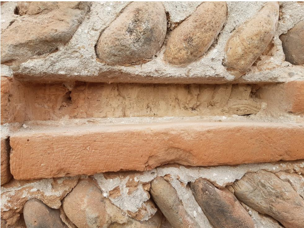
Etape 1 : creuser la brique abimée sur une profondeur d'environ 6 cm
